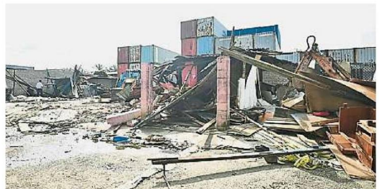
尽管市议会已发出警告信要求清空单位，但业者依然不听劝，市议会唯有到现场拆除非法建筑，杜绝后患！
